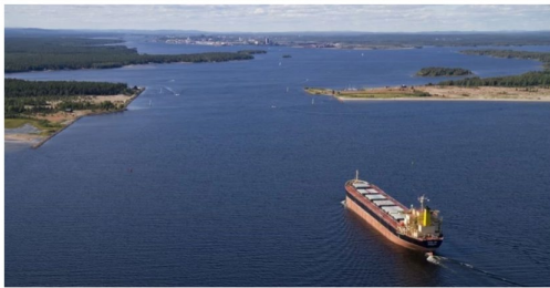
Projekt Malmporten, muddringen av farleden innanför hamngränsen och bygget av en ny djuphamn kommer att kosta Luleå Hamn drygt 1,3 miljarder kronor. Foto: Spårarsveket
