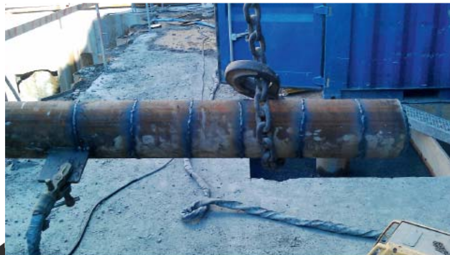
Figur 7.7. Bunnpel under utførelse - påleggssveis ("sveiselarver")
