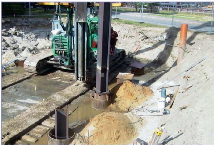
Figur 6.0.2: Stålrør for omstøp av HP-peler
