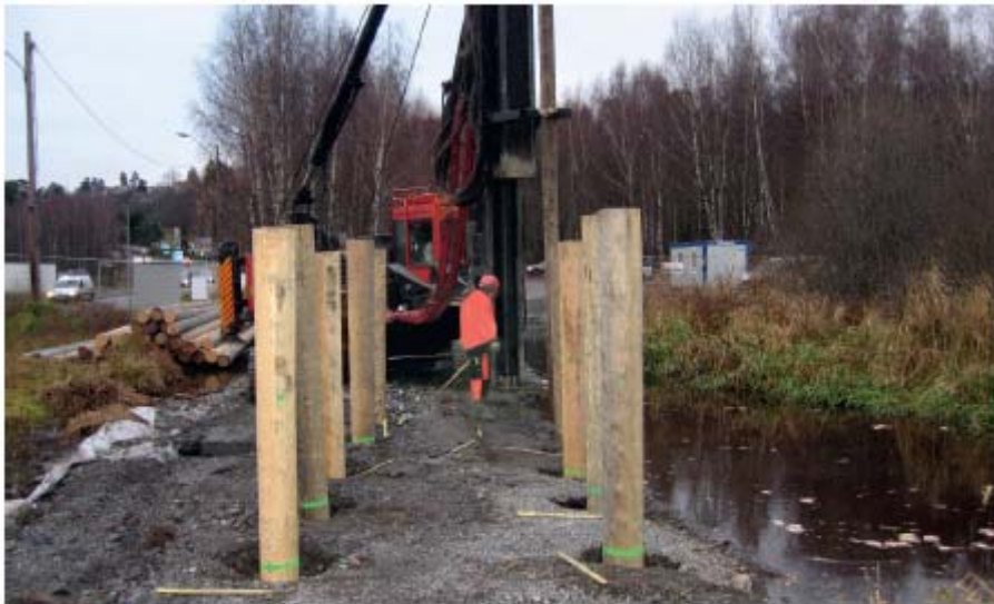
Figur 10.5 Ramming av trepeler for trelandgang ved Østensjøvannet i Oslo, 2009
