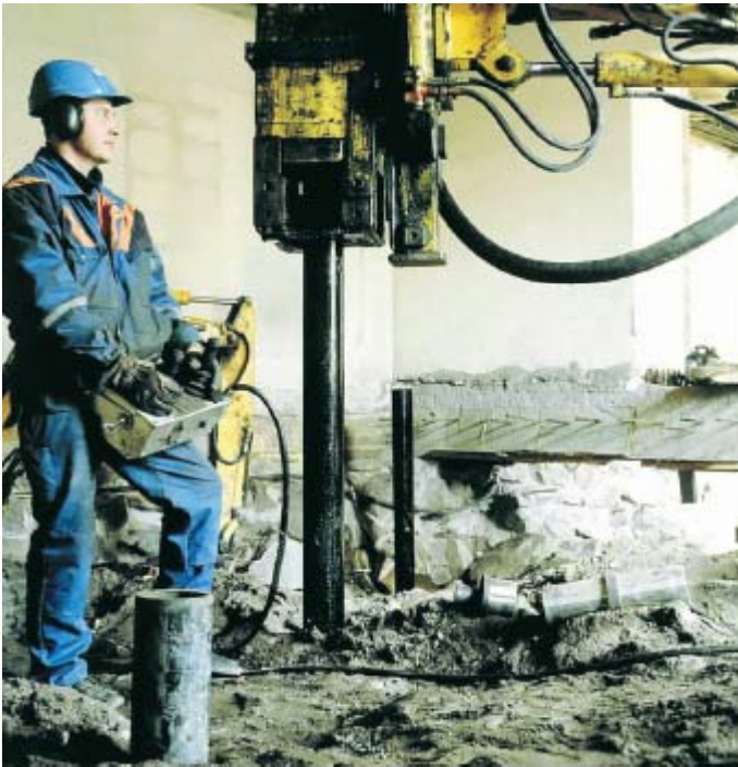
Figur 8.1. Installasjon av mikropeler inne i bygning
